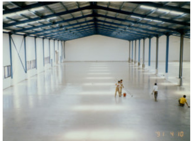
Bodenbeschichtung in Lagerhallen, Batam, Indonesien, 12'000 m 2
