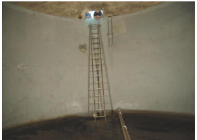
Curtins, Trinkwasserreservoir, Betonsanierung und Innenbeschichtung 350 m<sup>2</sup>
