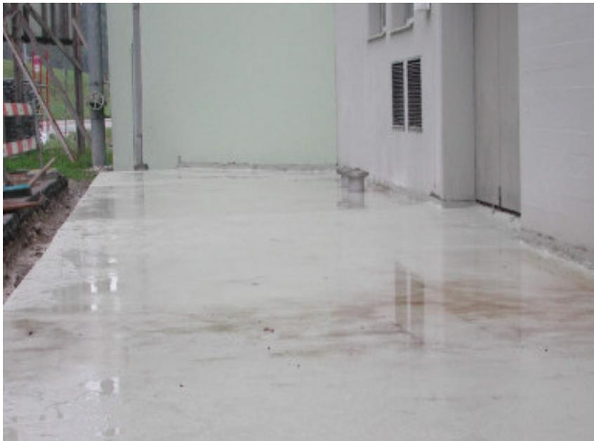
(Rissüberbrückende Abdichtung unter Zementüberzug, ARA Au, St. Gallen)
