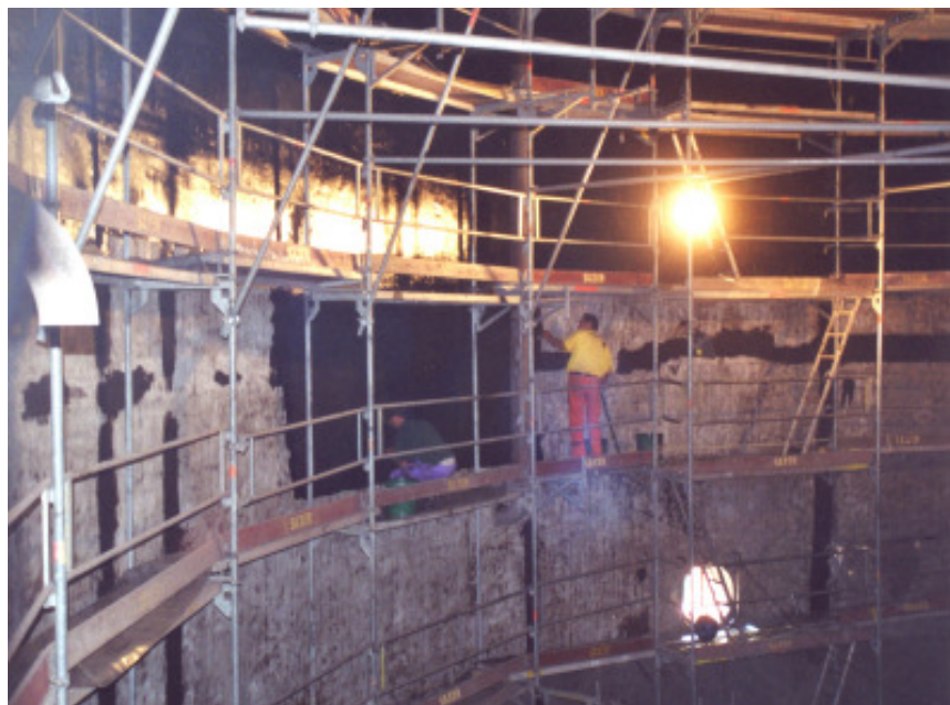
(ARA Worblental, Faulturm Innenbeschichtung, tot 3'300 m 2 )
