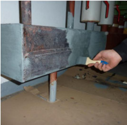
Korrosionsschutz an Eisenteilen
