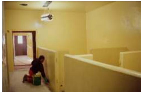
Virusinstitut IVI Mittelhäusern, Stallungen, dekontaminierbare und gasdichte Beschichtungen an Decken, Wänden und Böden mit VIBAPOX Multi Layer System
