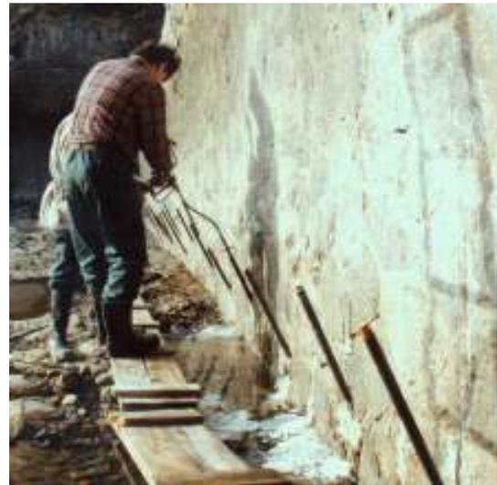
Injektion von VIBAPUR INJECT 2PE über vorversetzte Eisenrohre
