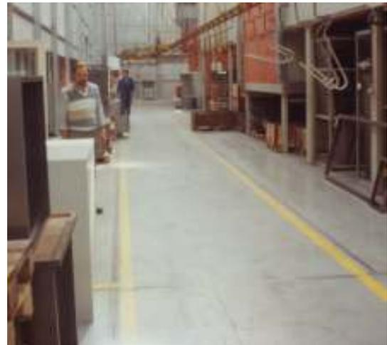
Lista AG Degersheim, VIBALIT 3E Industrieboden, direkt auf Beton aufgebracht, 8'540 m<sup>2</sup> (1978)
