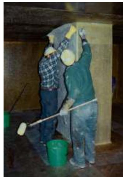
KVA Limmattal, Auffangbehälter, chemikalienbeständige Gewässerschutzauskleidung mit VIBAPOX LAMINAT EL3
