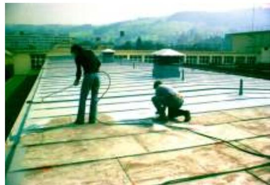
Landis & Gyr AG Zug, Blechdach, Korrosionsschutz und Falzabdichtung mit VIBAFLEX L, ART 50.41, 1600 m<sup>2</sup> (1979)
