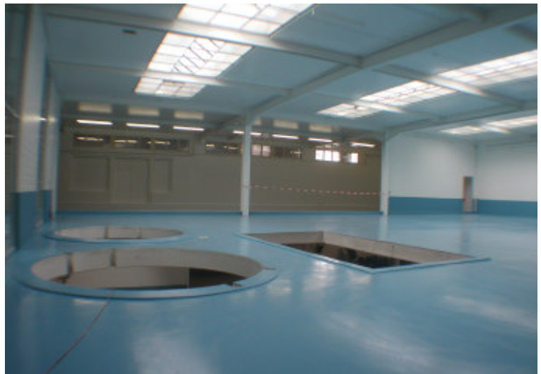
Fertiger Bodenbelag vor dem Einbau der Anlagen
