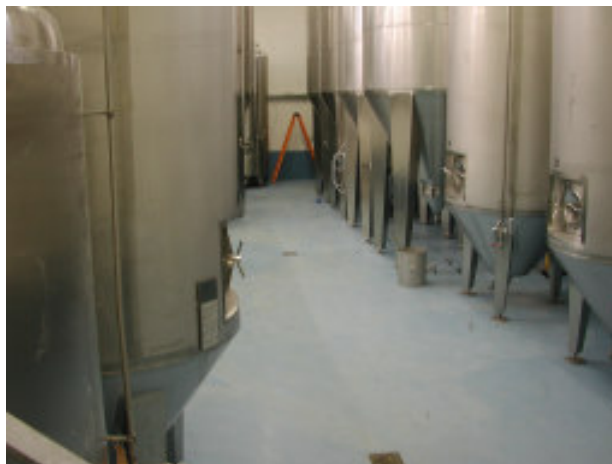
Bodenbelag im Tanklager im Kellergeschoss
