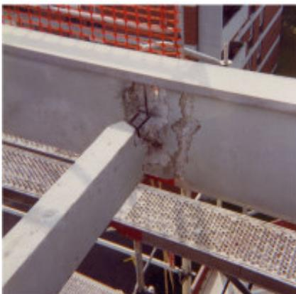
Sulzer Immobilien Zuchwil, Sanierung von Pergola Dachträgern mit VIBAXIT E, Epoxy Giessmörtel
