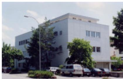
Post Telecom Gebäude Dietikon, Fassadenbeschichtung, rissüberbrückend mit VIBAFLEX L, tot 1'181 m<sup>2</sup>
