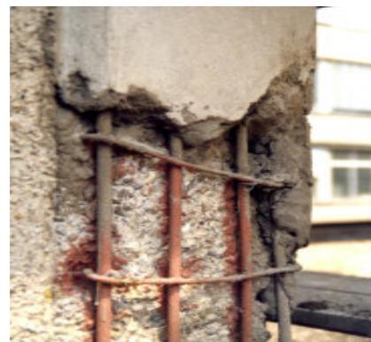
Bally Schönenwerd, Korrosionsschutz und Reprofilierungen an Betonpfeilern,
