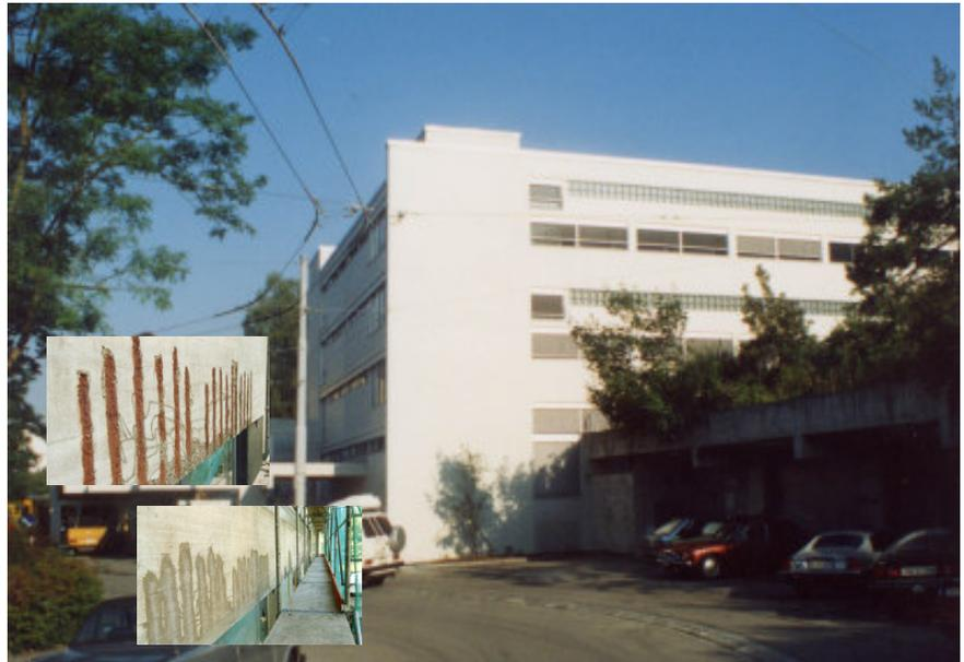
Postgebäude Hirslanden, Zürich, Betonsanierung und Fassadenbeschichtung mit VIBAFLEX F, tot 3'250 m<sup>2</sup>
