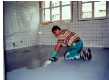
Einbau der farblosen Schlussbeschichtung an einem VIBALIT COLOR Epoxy Belages
