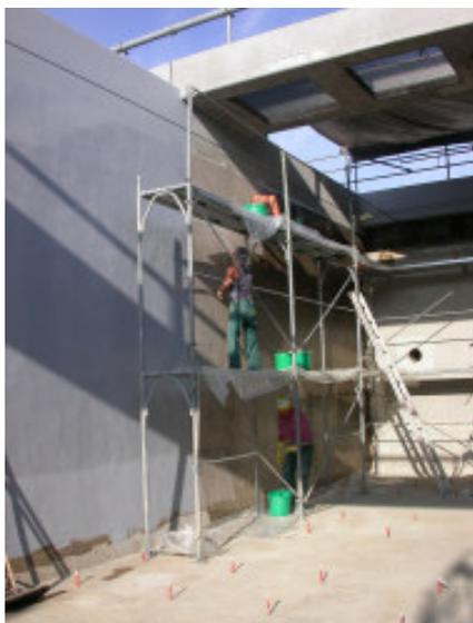
Spachtel- u. Beschichtungsarbeiten, ARA Regensdorf Belüftungsbecken.
