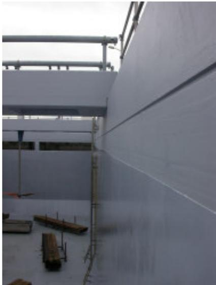
Trennlinie zwischen VIBAPOX Multi Layer System im Wasser und VIBAFLEX System ausserhalb des Wassers. ARA Regensdorf Belüftungsbecken.
