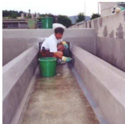
Betonsanierung und Spachtelarbeiten am Belüftungsbecken ARA Bischofszell
