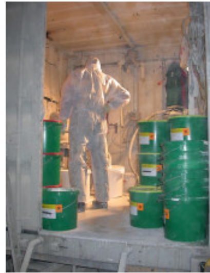
Misch- und Airless Arbeitsplatz im Fahrzeug integriert
