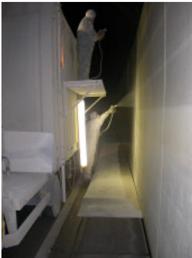
Spritzen auf 2 Ebenen von einem LKW Spezialfahrzeug
