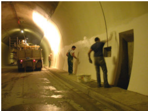
Spachtelarbeiten mit VIBQPLAN AQUAPOX TU, ART 40.24
