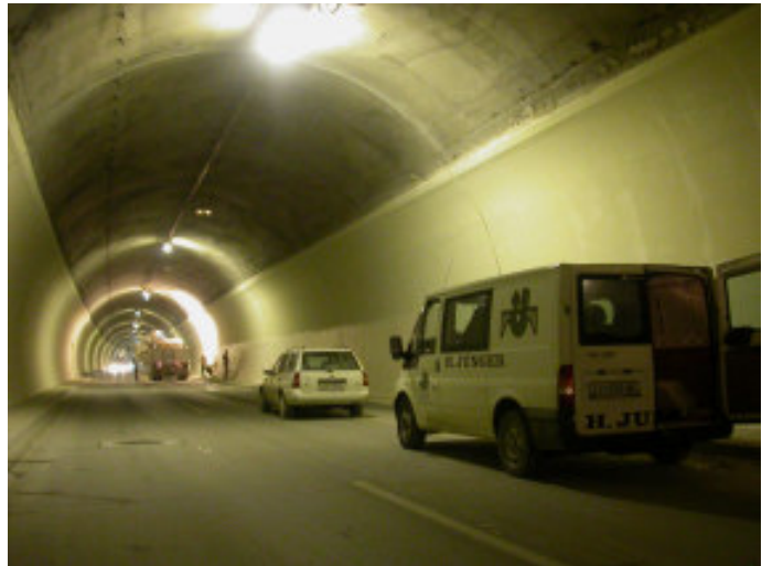
Ambergtunnel, A 14, Österreich, Spachtel-arbeiten mit VIBAPLAN AQUAPOX TU, und Beschichtungsarbeiten mit VIBACOAT AQUAPOX TU, (24'000 m 2 )
