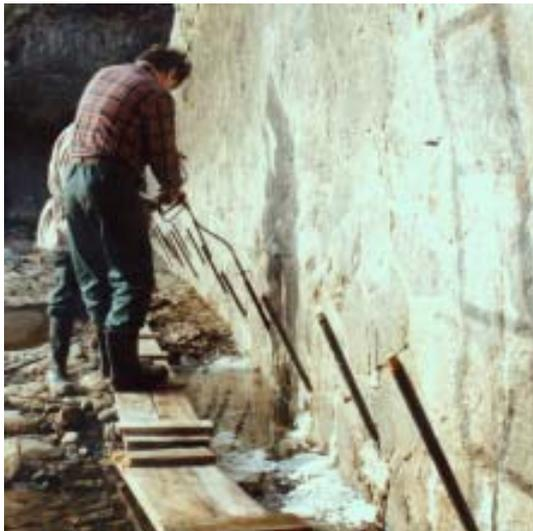
**Anwendung:** Verklebung und starre Verfüllung von Rissen, Hohlräumen und losen Betonteilen.
