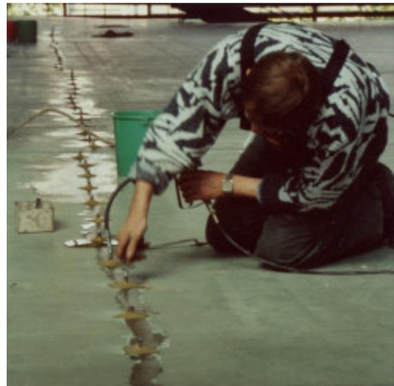
**Anwendung:** Kraftschlüssige Verklebung und starre Verfüllung von Rissen, Hohlräumen, hohlen Betonteilen oder Böden. Wasserführende Risse müssen zuerst mit VIBAPUR INJECT 2P, ART 47.32.000 vorabgedichtet werden.
