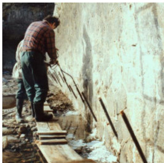
**Anwendung:** Zum Stoppen von fließendem Wasser und zur flexiblen Abdichtung von eindringender Feuchtigkeit bei Rissen, Hohlräumen, Arbeitsfugen in Beton bei Staumauern, Tunnels, Stollen, erdüberdeckten Bauten wie Tiefgaragen, Unterkellerungen oder bei Tiefbauten die im Grundwasserbereich liegen.
